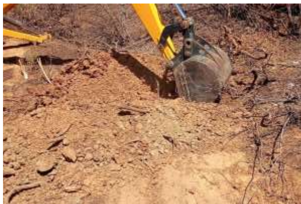
FOTO 24 – Material de 1ª categoria. Solo areno-siltoso, marrom claro, cascalhoso. Espessura = 0,80 m.
